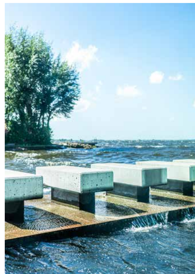
Aan de linkerkant zijn 32 betonnen elementen geplaatst, als een soort damwand. Deze beschermt de ark bij harde wind tegen het water. De ark wordt omgeven door een houten vlonder.
